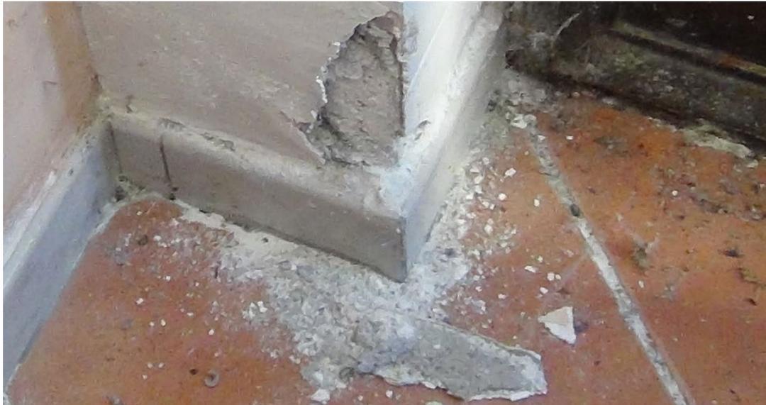
**Muro ammalorato da risalita capillare**
