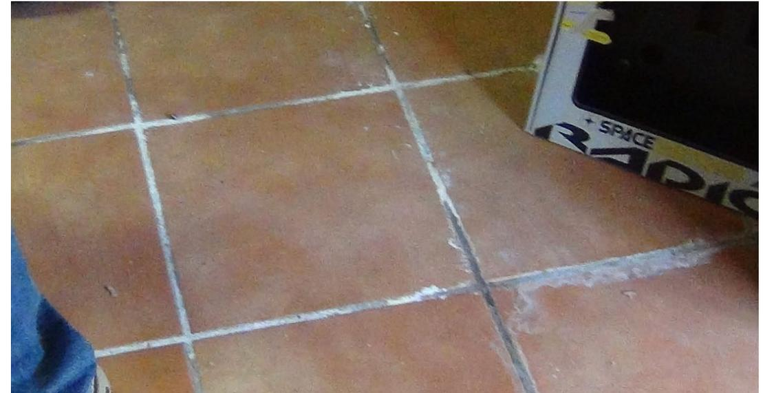
**Evidenti tracce di salnitro sulla fuga della ceramica**
