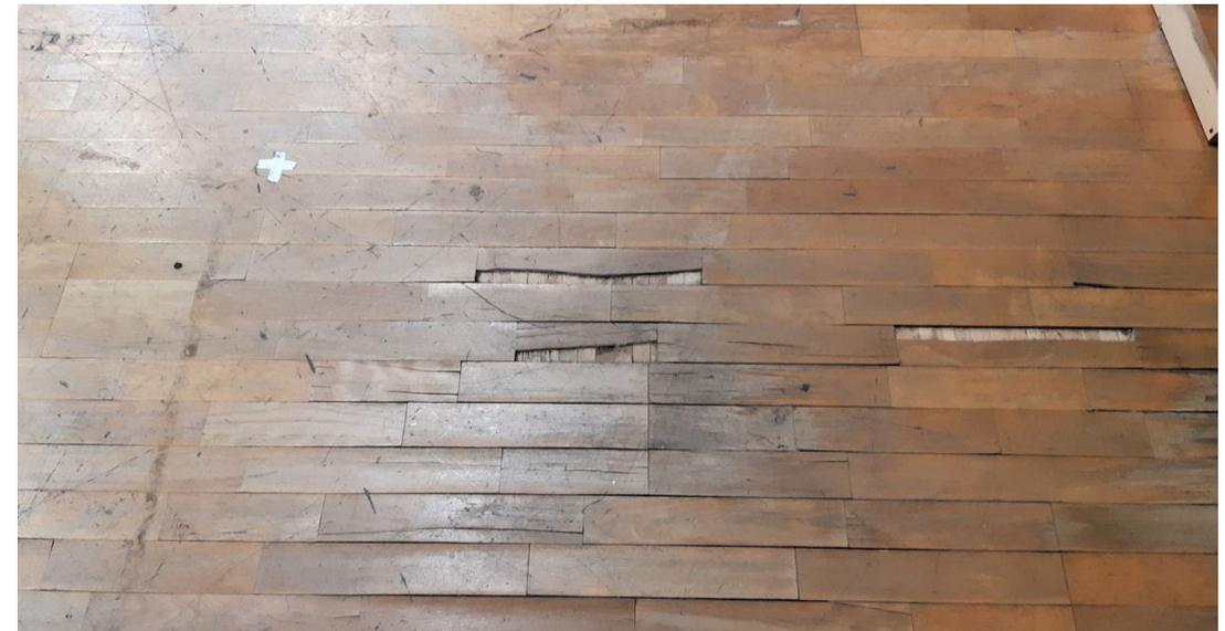
**Legno a tre strati flottante, evidenti ammaloramenti**
